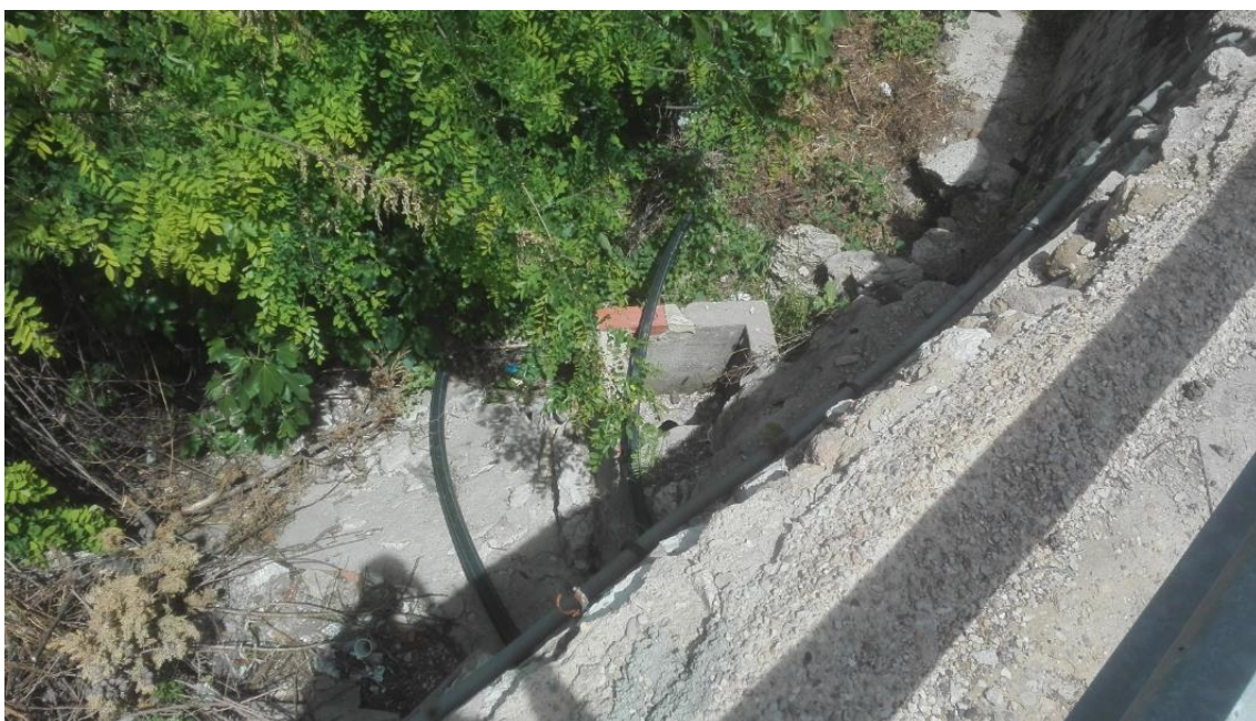
Ilustración 3: Red de distribución PE DN 45 mm cercana a la EBAR. Se aprecia otra línea de PE DN63 de la tubería de impulsión de la EBAR a la EDAR del municipio.
